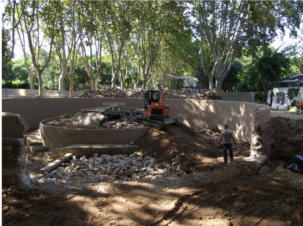
Fotografia 13. Detall dels treballs de demolició del fossar dels mandrils.
