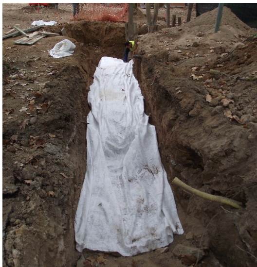
Fotografia 40. Detall de la contraescarpa un cop realitzat el cobriment indefinit de l'estructura.
