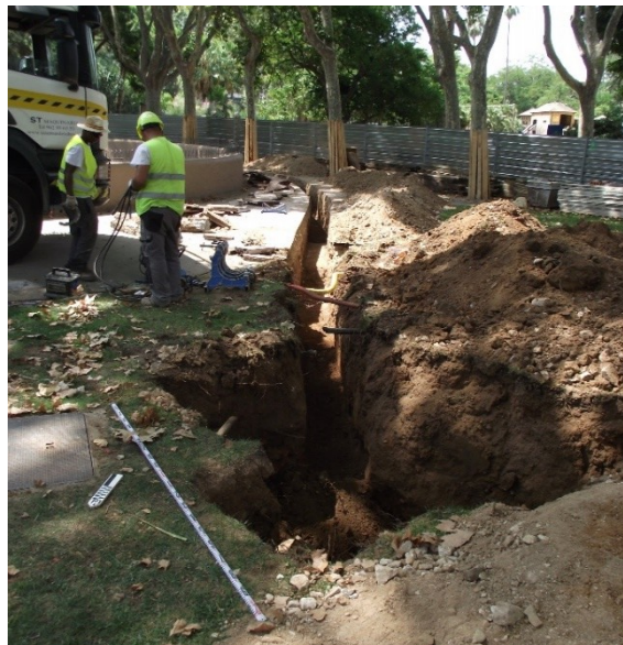
Fotografia 14. Detall de la rasa de substitució del tub d'aigua amb arqueta 1 al davant.
