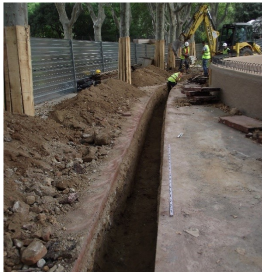
Fotografia 4. Detall del buidatge de la rasa de substitució pel nou tub d'aigua.
