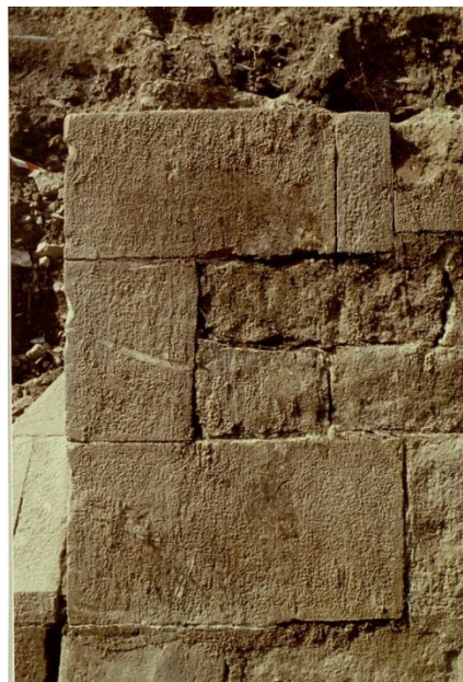
Fotografia 32. Detall de la cantonada del pont d'accés a la porta principal de la fortificació documentat a la intervenció de l'any 1986. Foto Martí Llorens.
