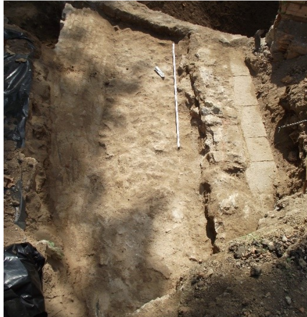
Fotografia 27. Detall en planta d'una de les voltes del pont de pedra.
