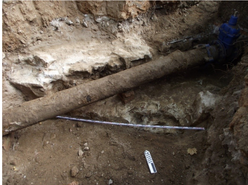
Fotografia 15. Detall del mur U.E.106 on es pot apreciar la important afectació que té l'estructura per part de la instal·lació d'aigua que es substitueix durant els treballs.
