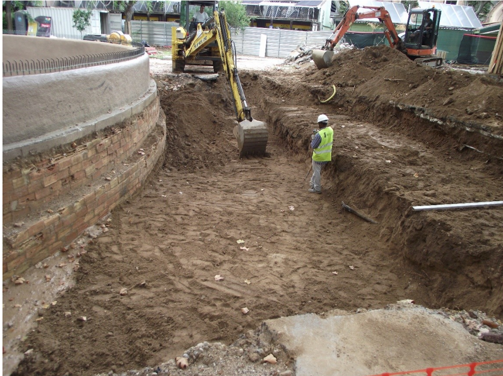
Fotografia 11. Detall de la màquina realitzant el buidatge de terres de la plataforma 1.
