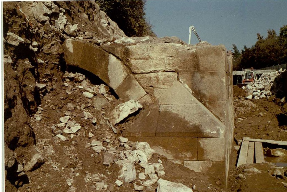
Fotografia 31. Detall del pont d'accés a la porta principal de la fortificació documentat a la intervenció de l'any 1986. Foto Martí Llorens.
