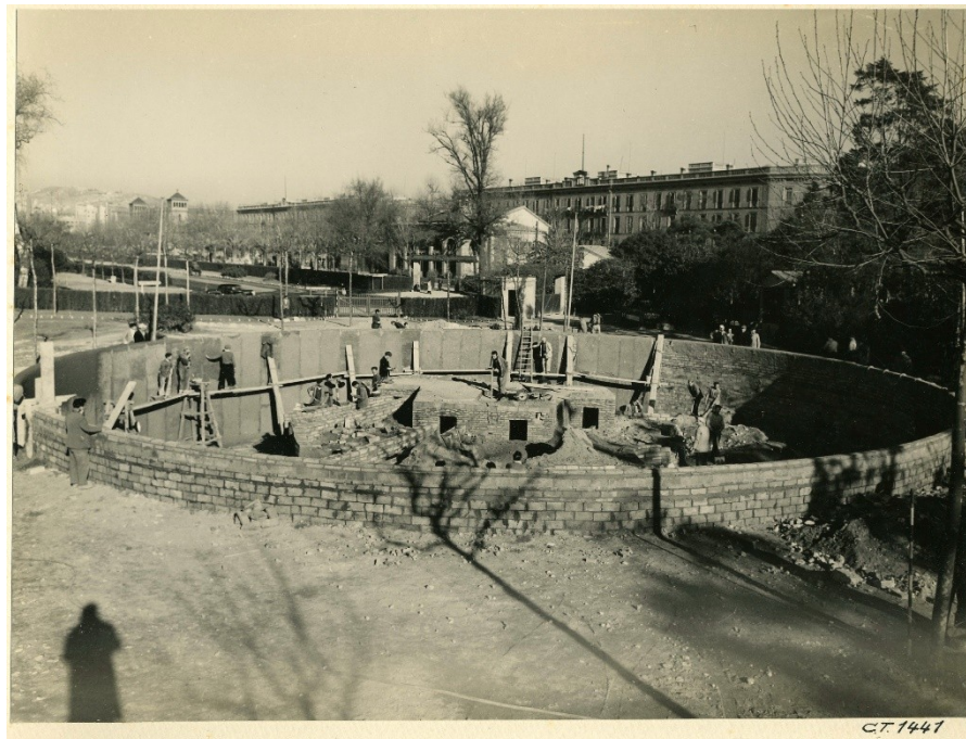
Fotografia 44. Fotografia de mitjans del segle passat del moment de construcció del fossat dels mandrils que es va enderrocar durant la nova remodelació de l'espai. Fons històric del zoo de Barcelona.
