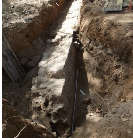
Fotografia 17. Detall longitudinal de la contraescarpa de la ciutadella.
