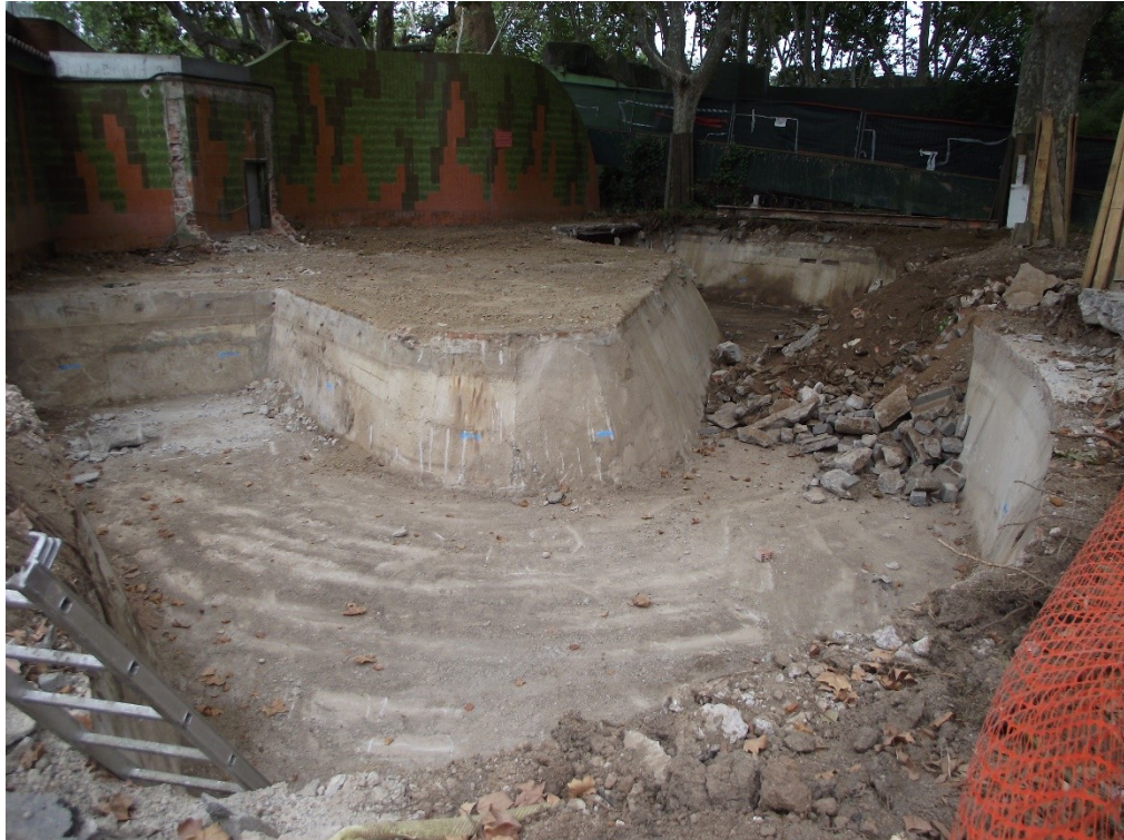
Fotografia 3. Detall de l'antiga instal·lació del zoo que es reomple amb terres durant la intervenció i que correspon amb la ubicació de la plataforma 3.
