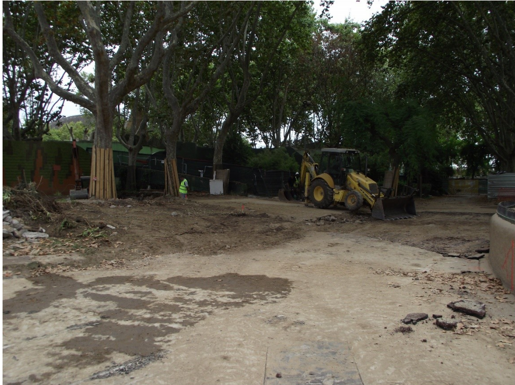
Fotografia 9. Detall de la zona afectada abans de començar el buidatge de terres de les plataformes per fer els pilotatges.
