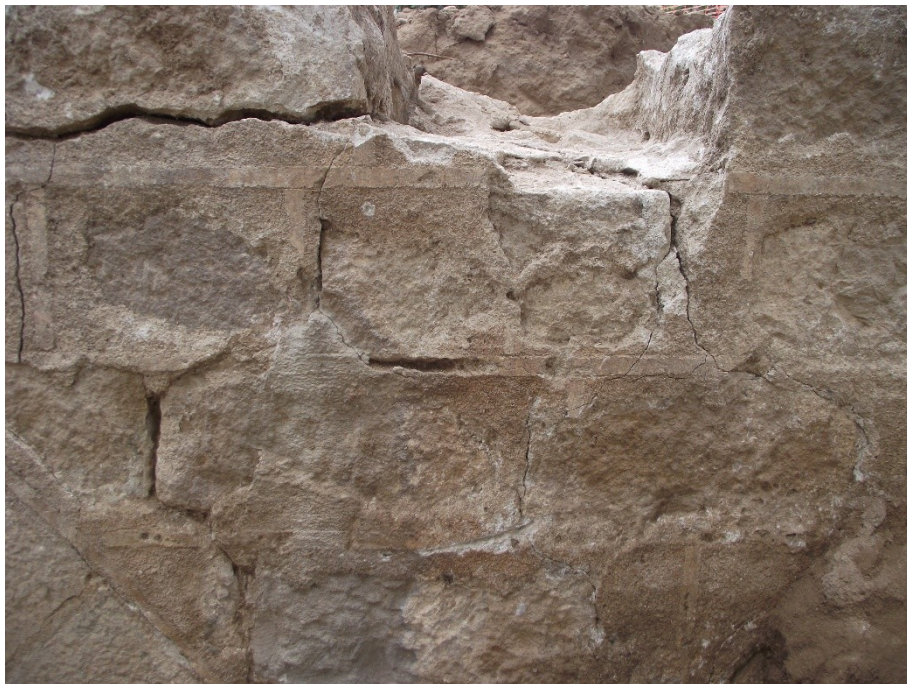
Fotografia 42. Detall del encintat corresponent a l'alçat del pont.
