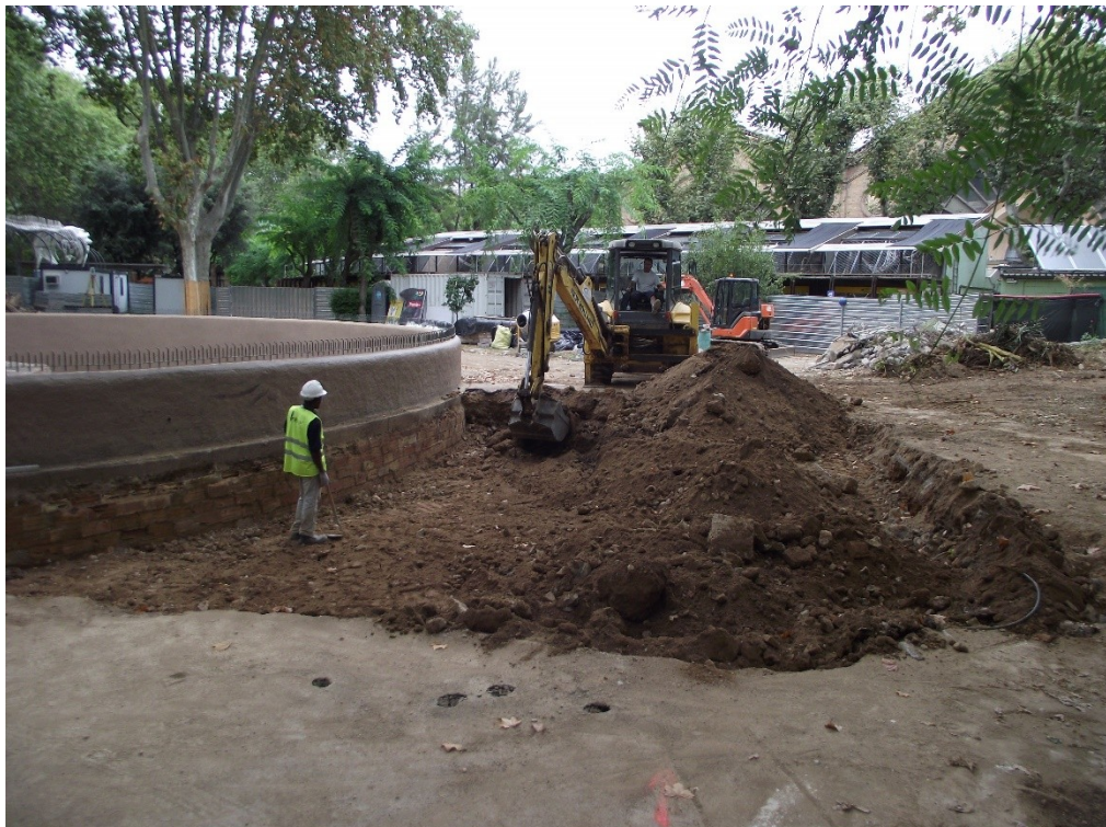
Fotografia 10. Detall de la màquina realitzant el buidatge de terres de les plataformes.
