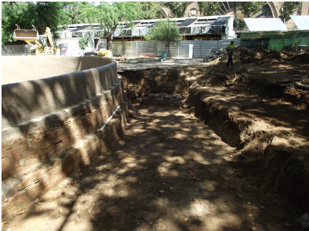
Fotografia 12. Detall de la plataforma 1 i 2 després del buidatge de terres.
