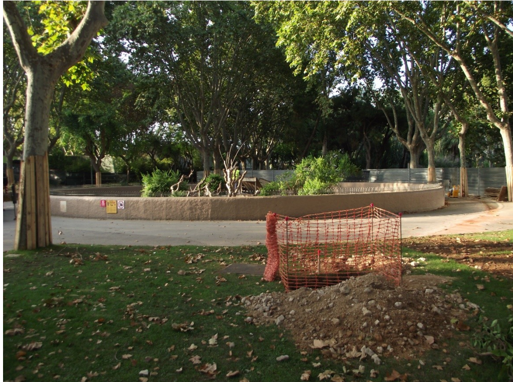
Fotografia 1. Detall de la zona afectada abans de començar els treballs.
